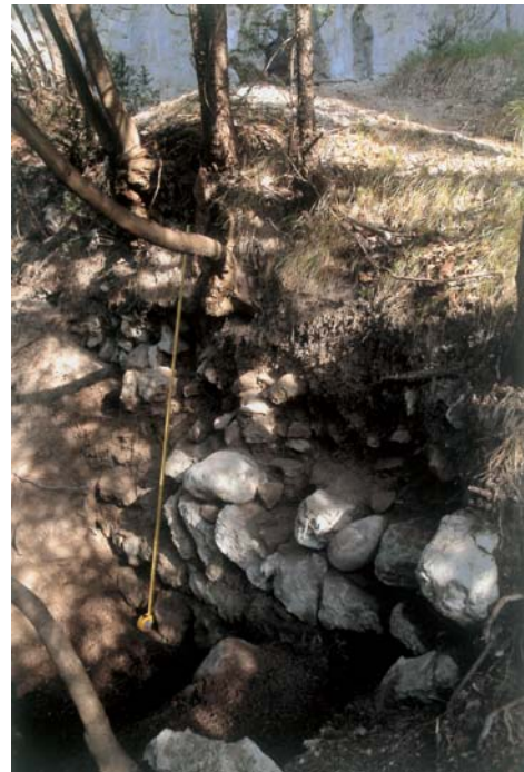
Fig. 7 - Grotta di Borghetto: muro legato in malta di calce idraulica e sabbia.
