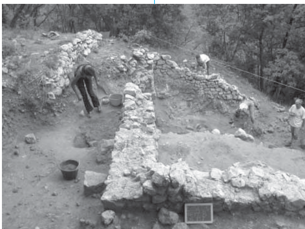
Settore B. Panoramica dell'edificio in corso di scavo.
