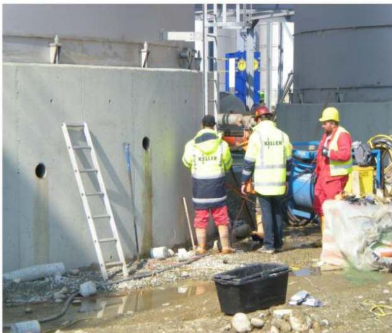
Esecuzione delle perforazioni per la realizzazione delle iniezioni di compensazione
